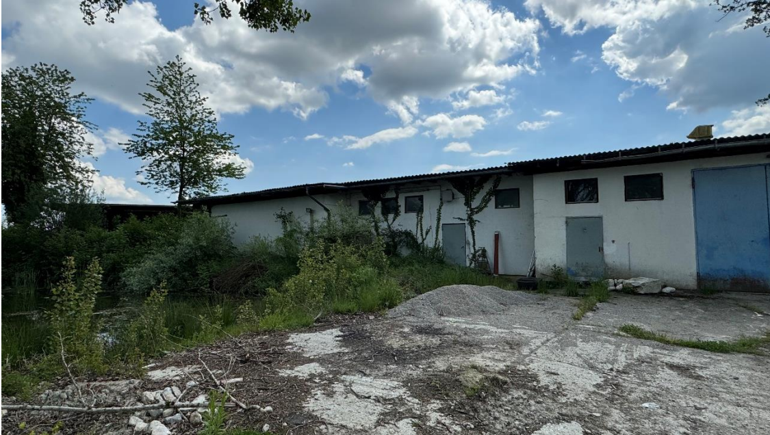
Abb. 3 Foto: Nordseite Hauptgebäude
