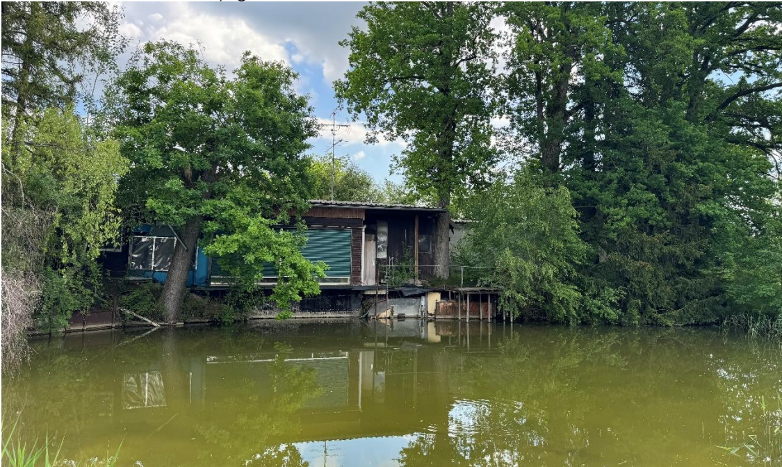
Abb. 4 Foto: Blick von West nach Ost – Zukünftiger Standort Gebäude D
